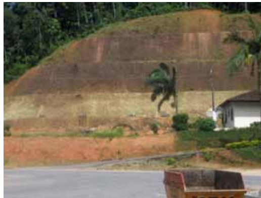
Figura 4.1 Movimento de solo para construção (CORDEIRO, 2007)
