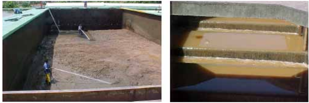
Figura 2.11 Remoção das partículas presentes na água bruta nos decantadores e filtros em ETAs (CORDEIRO, 1993)
