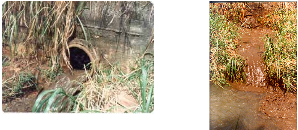
Figura 2.12 Lançamento de resíduos gerados em ETAs em águas superficiais (CORDEIRO, 1993)
