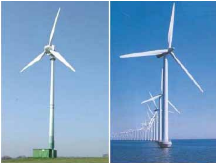
Figura 5.7. Sistema de energia eólica (disponível em: < www.eolica.com.br >. Acesso em: 11 mar. 2009)
