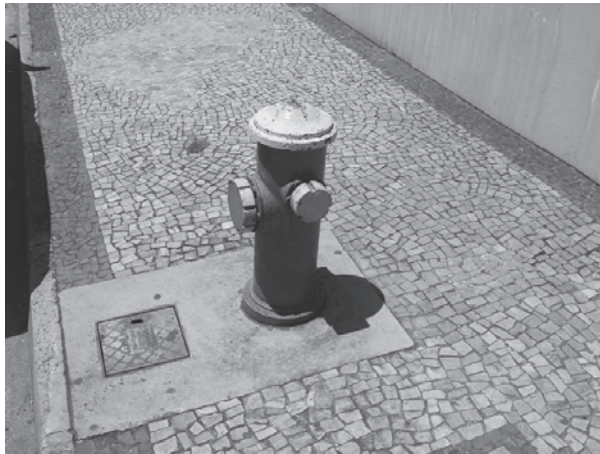
Figura 2.74 Hidrante de coluna.
