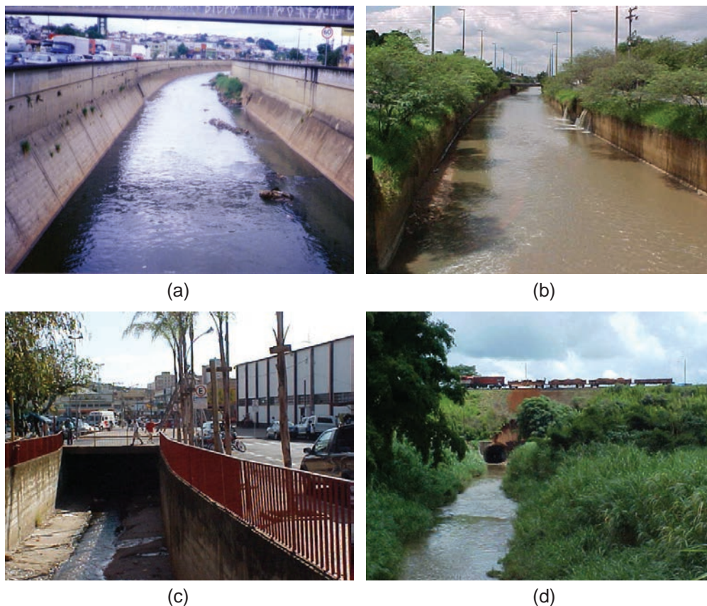
Figura 4.21: Algumas tipologias empregadas na macrodrenagem urbana: (a) Canal artificial aberto – Seção mista; (b) Canal artificial aberto – Seção retangular; (c) Canal artificial fechado – Seção retangular; (d) Canal natural.
