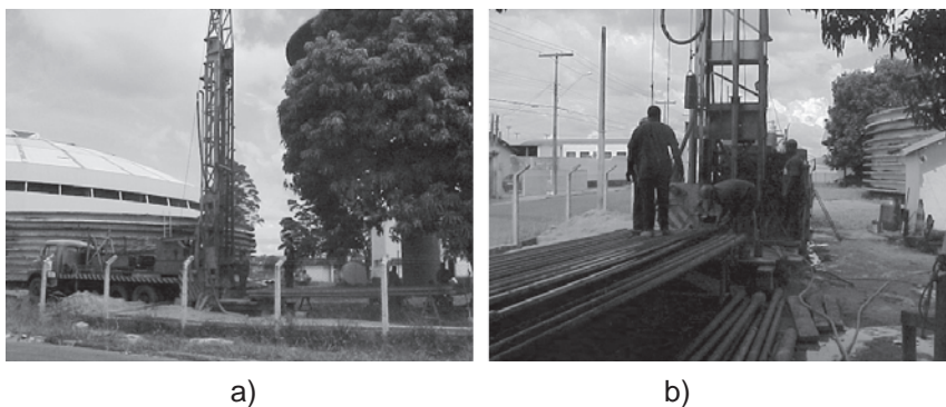
Figura 2.14 Perfuração de poço profundo, na Vila Alpes – São Carlos (SP).
