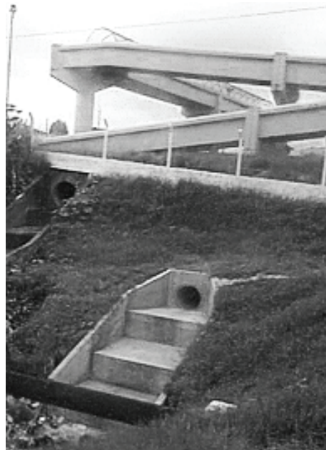
Figura 4.16 Dissipador de energia – São Carlos (SP).
