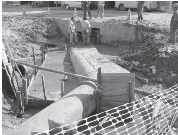
Figura 2.28 Construção de bloco de ancoragem.
