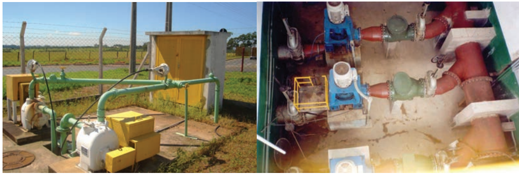
Figura 3.21 Detalhes de uma EEE de poço seco.
