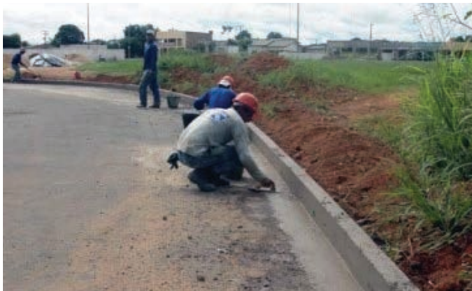
Figura 4.12 Sarjeta e meio-fio moldado in loco .
