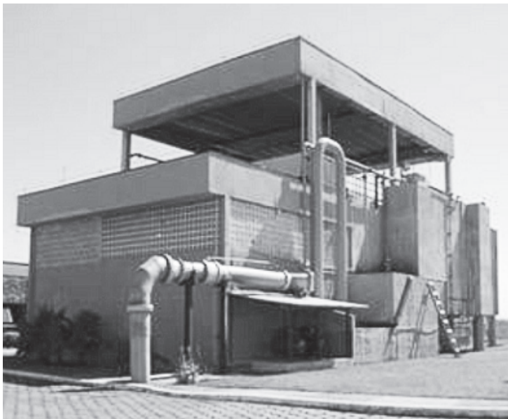
Figura 2.53: ETA baseada em Floto-Filtração – Jaú (SP)
