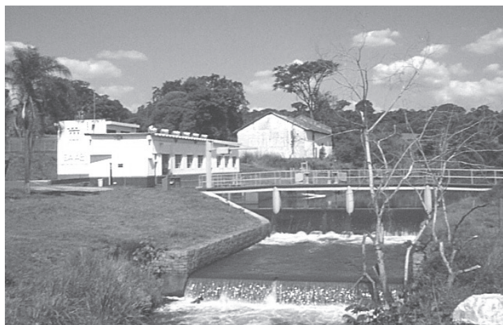
Figura 2.19 Captação no Ribeirão Feijão – tomada-d'água com barragem de nível, em São Carlos (SP).
