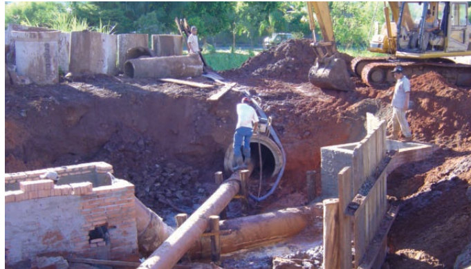
Figura 3.18 Sifão invertido construído sob galeria de água pluvial.
